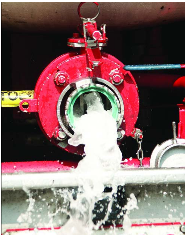
Eine perfekte Tankreinigung setzt moderne Technik, versiertes Personal, die richtigen Verfahren und viel Erfahrung voraus.
